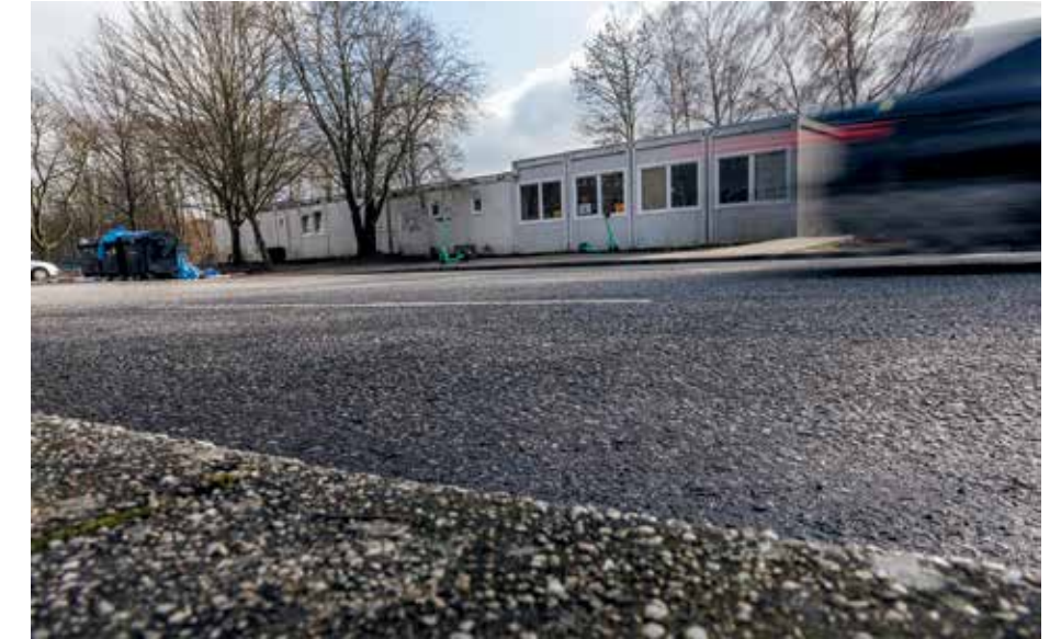
Einrichtung der Living Quarter GmbH aus Berlin für obdachlose Menschen am Kieler Hauptbahnhof.
